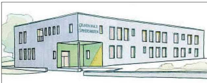
Keine Lichtbänder mehr: Der sanierte Schulbau samt Anbau mit neuem Eingang (links) hat eine gedämmte Fassade mit Einzelfenstern.
