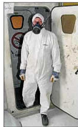
Vorsicht, Schadstoffe: Das Erdgeschoss kann derzeit nur durch eine Schleuse mit Sicherheitskleidung betreten werden.
